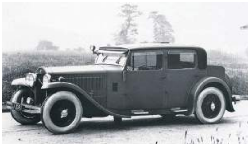
Nel 1932 la Dilambda firmata Gangloff Geneve, grazie alla robustezza del telaio, risolve le difficili criticità strutturali delle carrozzerie cabriolet a quattro porte. A destra, fedele alla costruzione con il sistema Weymann, questa berlina sport dell'inglese H.J. Mulliner mostra la particolarità delle pedane singole.
