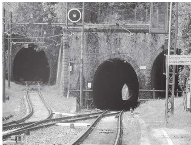
Quella di Corbezzoli è una delle stazioni che fecero l'epopea delle ferrovie italiane: ecco tre delle gallerie da tempo senza binari. O quasi...
